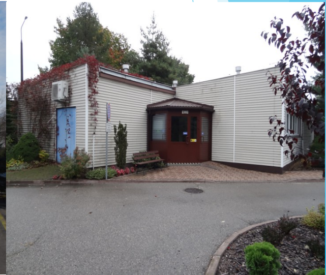
Zdj. Budynek zaplecza
