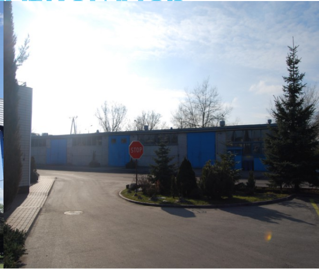
Zdj. Budynek magazynu z wiatą
