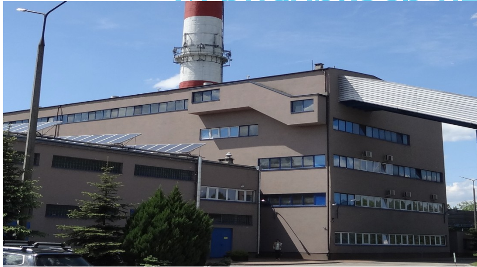
Zdj. Budynek centralnej ciepłowni wraz z budynkiem dostawczym
