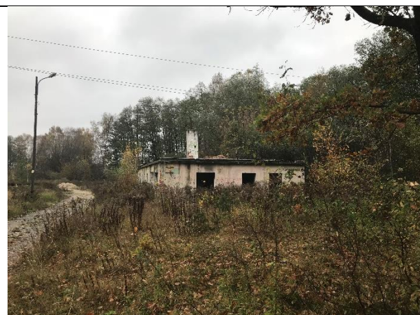
Fotografia nr 3 – widok od strony ul. Zielonej na tereny nieczynnej oczyszczalni ścieków
