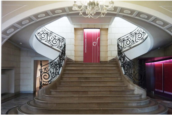
Stopnie schodów znaczone ciemnymi, kontrastującymi taśmami
