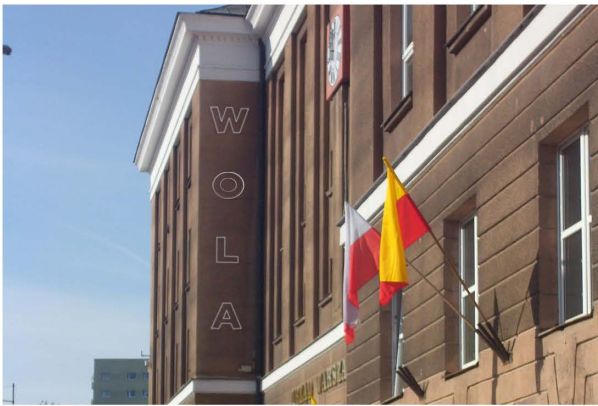
Neon na fasadzie głównej wspomagający identyfikację obiektu
