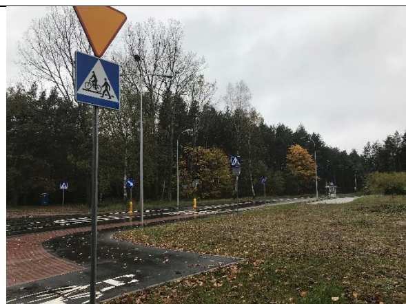
Fotografia nr 3 – widok od strony Alei Niepodległości na grunt leśny
