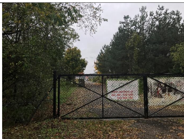
Fotografia nr 5 – widok na tereny niezabudowane
