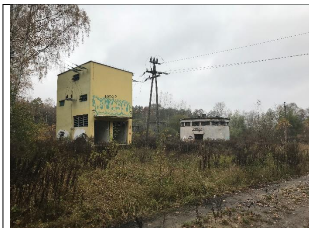
Fotografia nr 3 – widok od strony ul. Zielonej na teren nieczynnej oczyszczalni ścieków
