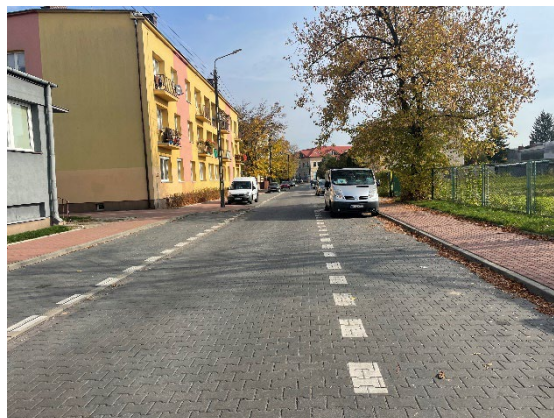
Ulica Mariańska – jednokierunkowa ulica z wyznaczonymi pasami postojowymi na jezdni. Rozwiązanie poprawne – ogranicza szerokość jezdni i na chodnikach pozostawiona jest przestrzeń dla pieszych. Brakuje natomiast elementów podnoszących jakość i estetykę przestrzeni, np. zastąpienie pasów postojowych krótszymi zatokami przedzielonymi zielenią.
