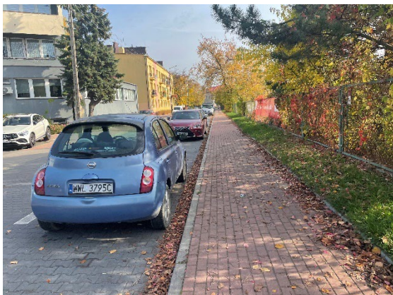
Ulica Mariańska – jednokierunkowa ulica z wyznaczonymi pasami postojowymi na jezdni. Rozwiązanie poprawne – ogranicza szerokość jezdni i na chodnikach pozostawiona jest przestrzeń dla pieszych. Brakuje natomiast elementów podnoszących jakość i estetykę przestrzeni, np. zastąpienie pasów postojowych krótszymi zatokami przedzielonymi zielenią.
