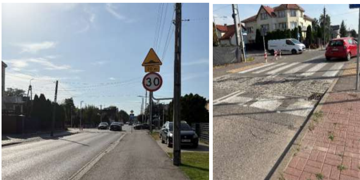
Ulica Lipińska - wyniesione skrzyżowania z ulicami Mickiewicza i Sikorskiego – rozwiązania poprawiające bezpieczeństwo ruchu.
