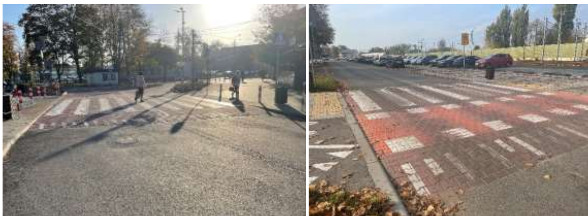
Wyniesione skrzyżowanie ul. Żelaznej i Legionów oraz przejście dla pieszych na ul. Żelaznej w rejonie skrzyżowania z ul. Danuty Siedzikówny „Inki” – rozwiązania poprawiające bezpieczeństwo ruchu.
