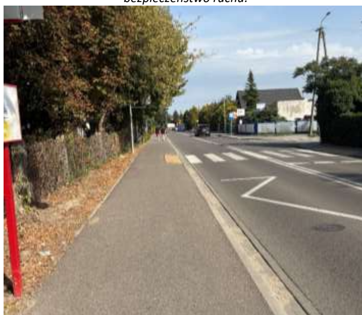
Ulica Lipińska, odcinki pomiędzy skrzyżowaniami – brak środków uspokojenia ruchu i ograniczenia prędkości.
