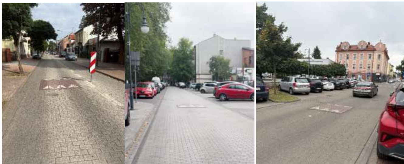
Progi zwalniające na odcinkach pomiędzy skrzyżowaniami: ul. Kościelna, Moniuszki, Plac 3 Maja – rozwiązania poprawiające bezpieczeństwo ruchu.
