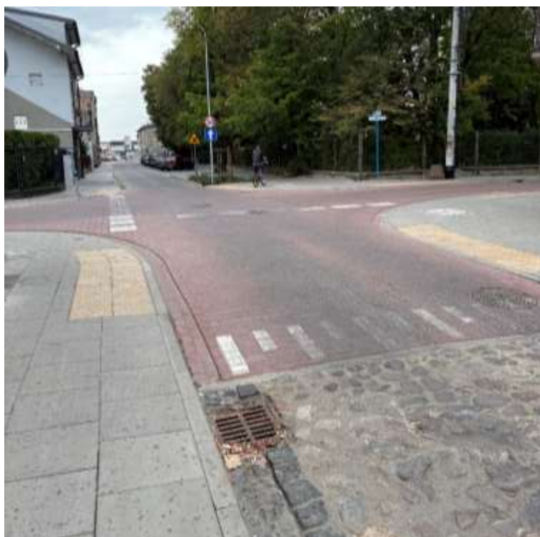
Wyniesione skrzyżowanie ul. Mickiewicza i Miłej – rozwiązania poprawiające bezpieczeństwo ruchu.
